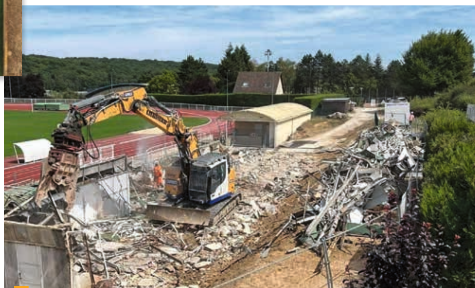
Les travaux de la tribune et de l'aménagement de l'accès au terrain d'honneur.
