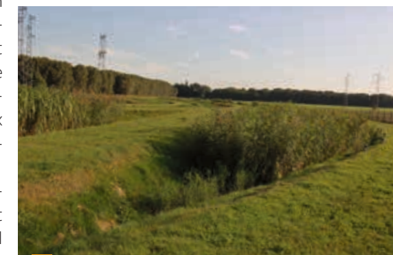
Les bassins de filtration de la STEP.
