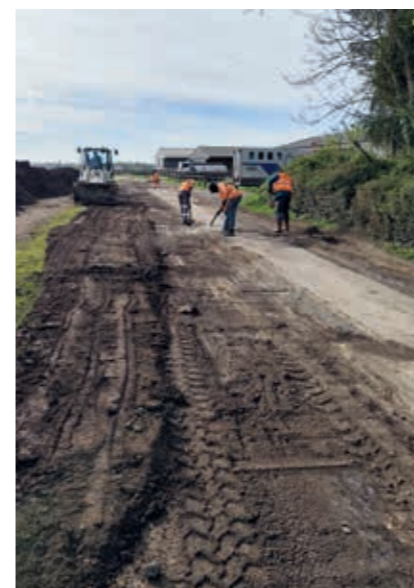
Route de la Bènerie, réfection de l'enrobé.
