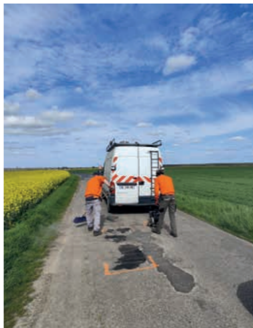
CV7 et CV9, comblement des trous de la chaussée.
