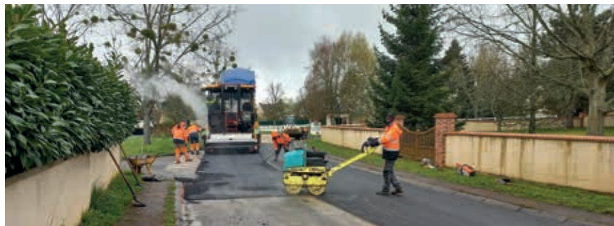
Rue du Hurepoix, nouvel enrobé sur plusieurs sections de chaussée et rebouchage des nids-de-poule plus isolés.
