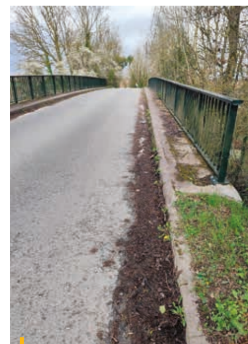
— Nettoyage des 3 ponts de la commune.
